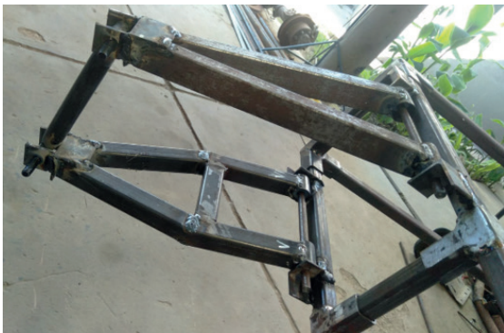
Figura 5. Montaje del sistema de tijerales al chasis
